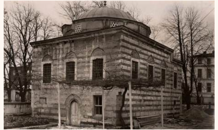
I. Mahmud tarafından 1740'lı yıllarda yaptırılan Ayasofya Sıbyan Mektebi binası (SALT Araştırma, Ali Saim Ülgen arşivi)
